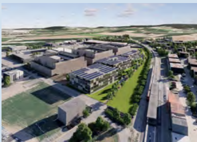
Das geplante Metro Data Center in Dielsdorf im Kanton Zürich
